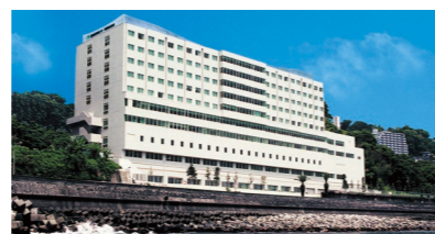
国際医療福祉大学熱海病院 (269床) 静岡県熱海市
