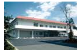
にしなすの総合在宅ケアセンター (栃木県那須塩原市)
